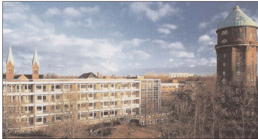
Das Krankenhaus Groß Sand, Geriatrie. Rechts etwas zurückgesetzt das Akut-Krankenhaus. Der Wasserturm, Wahrzeichen von Wilhelmsburg. Im Hintergrund die Türme von „St. Bonifatius“. Foto: Archiv Katharinenwestern
