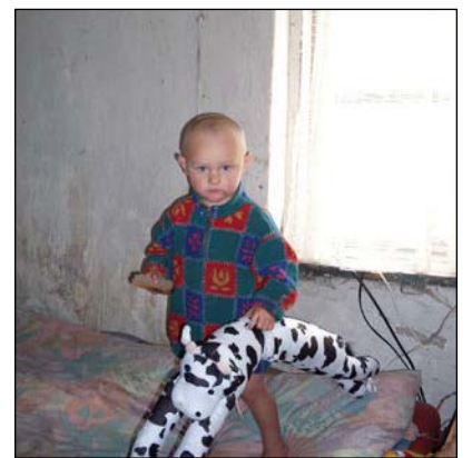
In dieser Einzimmerwohnung leben drei Kinder mit ihren Eltern. Die Wände sind feucht und schimmelig, die Elektrizität ist notdürftig installiert.
