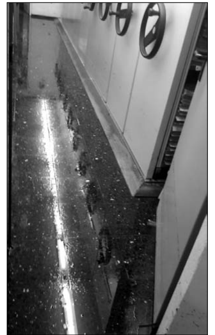
Rechts: Restwasser um und unter den Gleitregalen.
