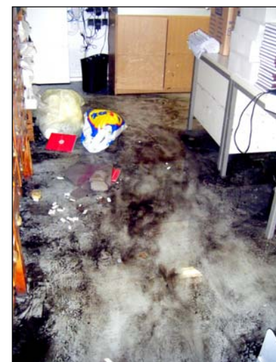
Schmutz und Dreck hinterließ die Wasserflut, die aus dem Schmutzwasserkanal über die Toiletten in die Kellerräume des Ermlandhauses eingedrungen war.
